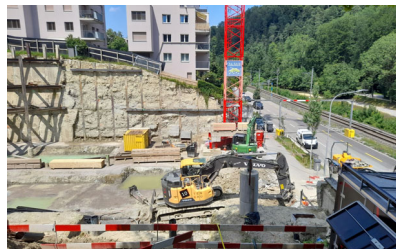
Zürich (ZH), Soodstrasse 90 bis 96: Baugrube
