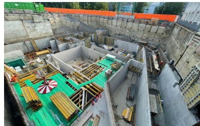
Baden (AG), Brown Boveri Platz 4: Baugrube
