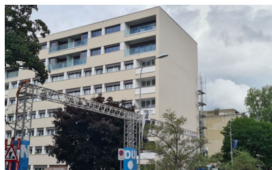
Meyrin (GE), Rue de la Prulay 39 und 45: Aufstockung
