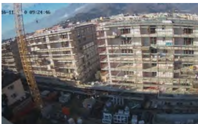
Locarno (TI), Via Bartolomeo Varenna 20a et 20b : Construction nouvelle
