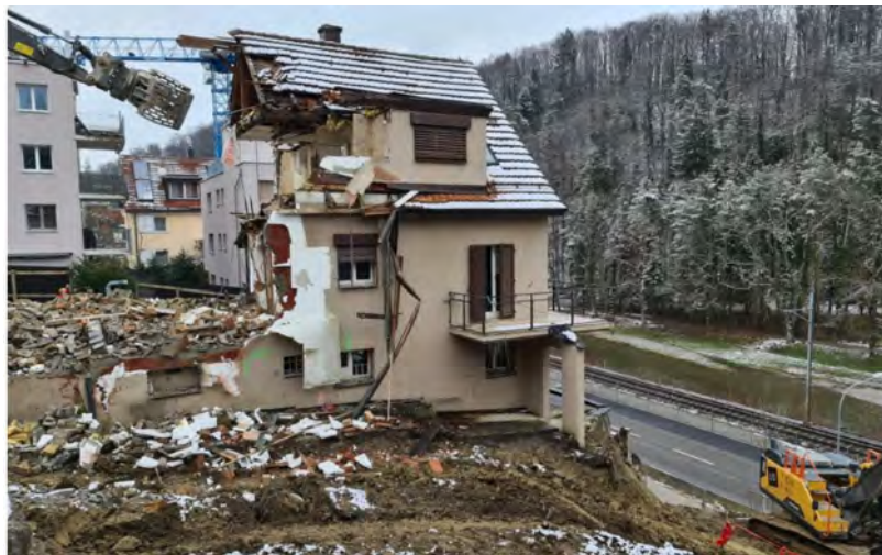
Zurich (ZH), Soodstrasse 90 à 96 : travaux de démolition
