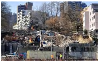
Zurich (ZH), Soodstrasse 90 à 96 : excavation
