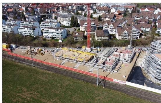
Fehraltorf (ZH), Wermatswilerstrasse 20: Neubau
