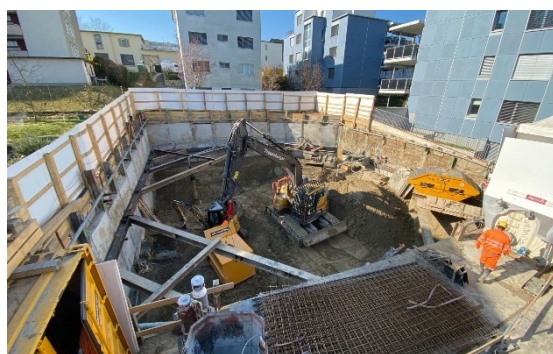
Zürich (ZH), Oberwiesenstrasse 63: Ersatzneubau
