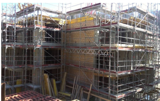
Zürich (ZH), Soodstrasse 90 bis 96: Neubau
