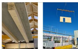
Konzept 'OneLiving': modulares Bausystem mit Holz-Beton-Verbund
