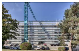
Pendant les travaux de surélévation
