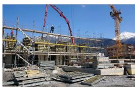
Pendant la construction
