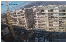
Pendant la construction
