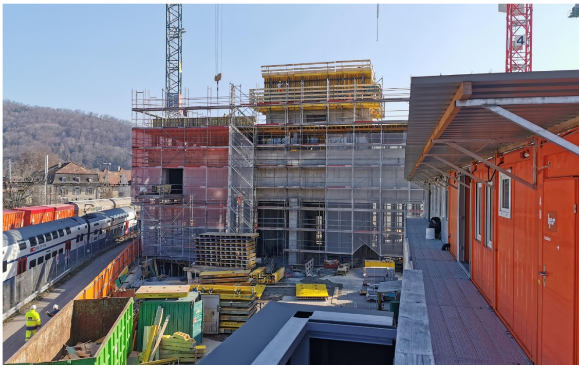
Baden (AG), « Akara Tower », Brown Boveri Platz 4 : construction nouvelle
