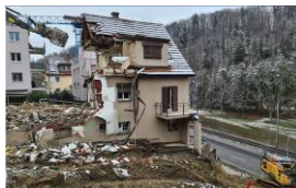
travaux de démolition
