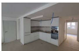
Nouveaux logements en RDC
