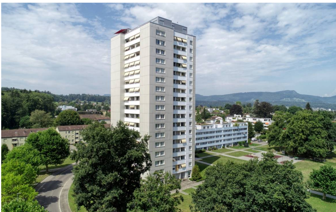
Aarau (AG), General Guisan-Strasse 31 | Année d'acquisition : 2019 | Valeur vénale : 29,14 millions de CHF | Logement
