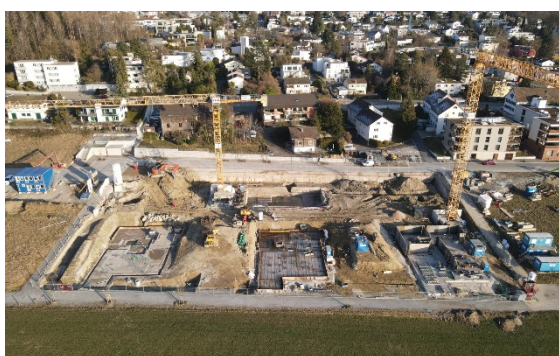
Uffikon (ZH), Leuen Waldegg : construction nouvelle
