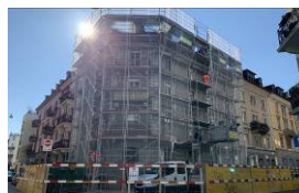
Pendant la rénovation
