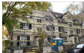
Pendant la rénovation
