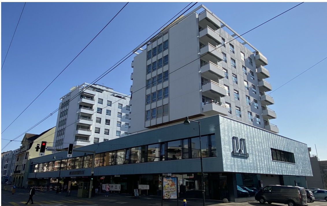
Birsfelden (BL), Hauptstrasse 28 et 30 | Année d'acquisition : 2017 | Valeur vénale : 40,20 millions de CHF | Logement
