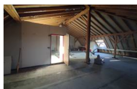
Aménagement des combles
