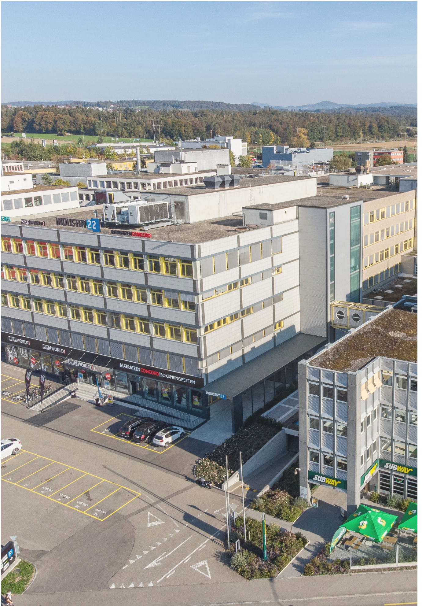
Volketswil (ZH), Industriestrasse 22 | Verkehrswert: CHF 46 Mio. | Mietertrag [SOLL]: CHF 3.2 Mio. | Mietfläche: 28'280 m 2 | Nutzung: Kommerz
