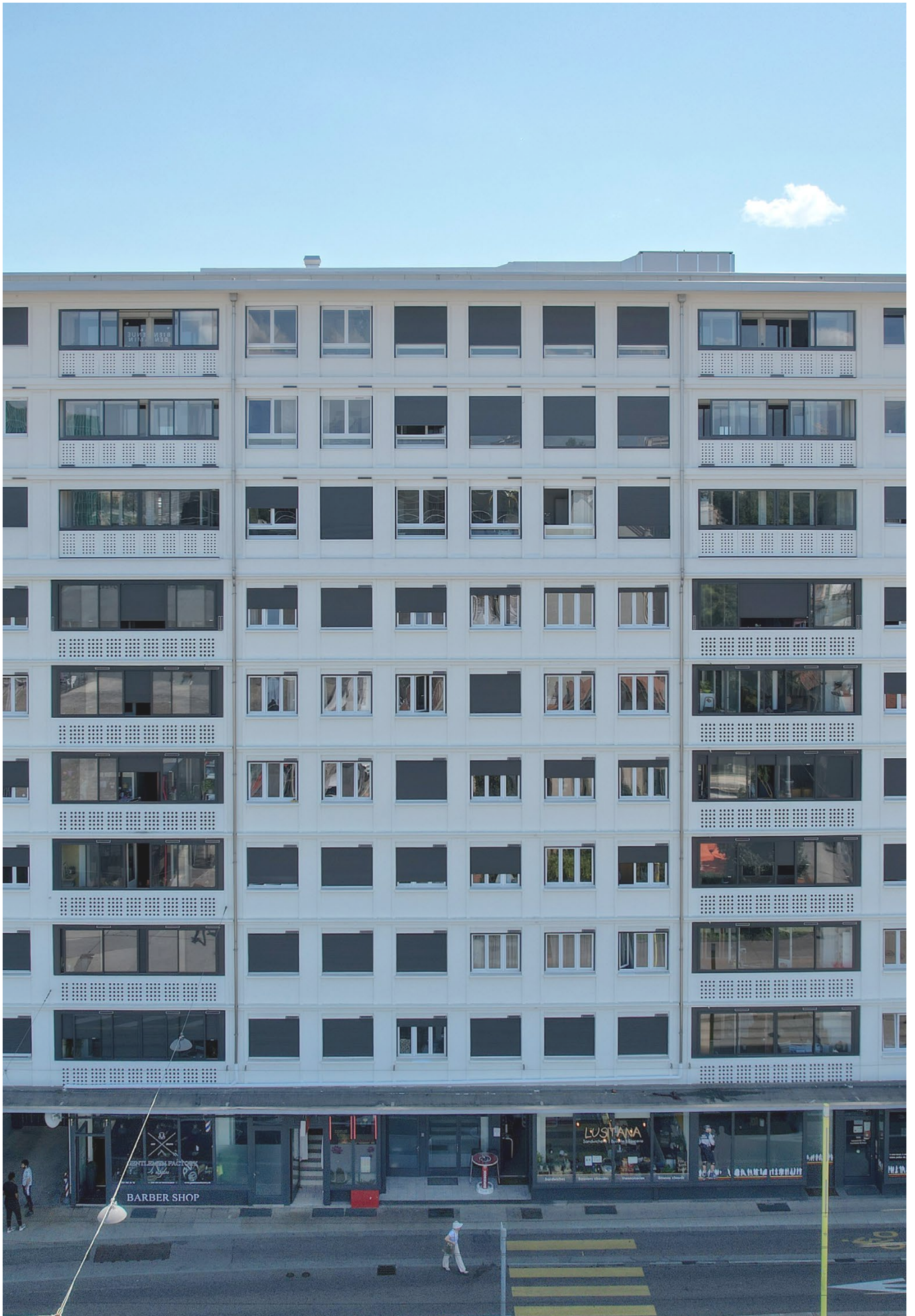
Carouge (GE), Route des Acacias 36 | Verkehrswert: CHF 46 Mio. | Mietertrag [SOLL]: CHF 1.1 Mio. | Mietfläche: 4'616 m 2 | Nutzung: Wohnen
